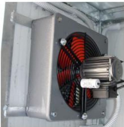
Ventilation intégrée avec contrôle automatique de température
